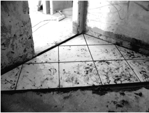
Անկյունագծային սալիկապատման գործընթացի հաջորդականությունը:
