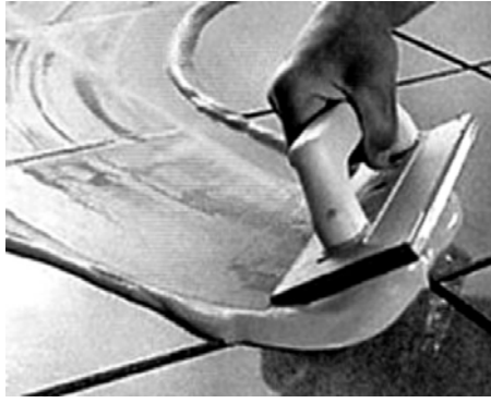
Միջապիկային կարերի լիցքը լցահարթիչային խառնուրդով:
